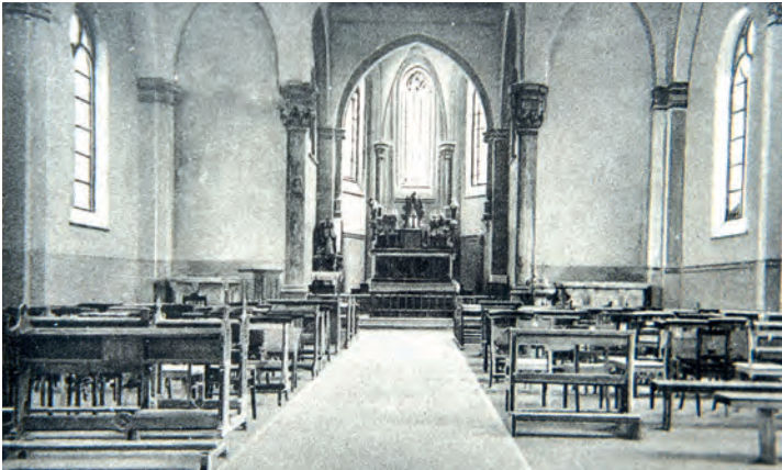
Innenansicht nach dem Neubau 1946
