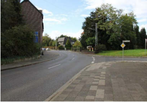
Abb. 115: Gefährlicher Knotenpunkt und fehlende Querungshilfen und Radinfrastruktur Fotos: Planungsgruppe MWM (2020)
