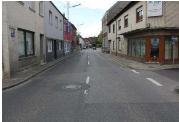
Abb. 95: Beispiel: Zu schmale Gehwege mit mangelnder Barrierefreiheit und fehlende Radinfrastruktur (Sittarder Straße)
