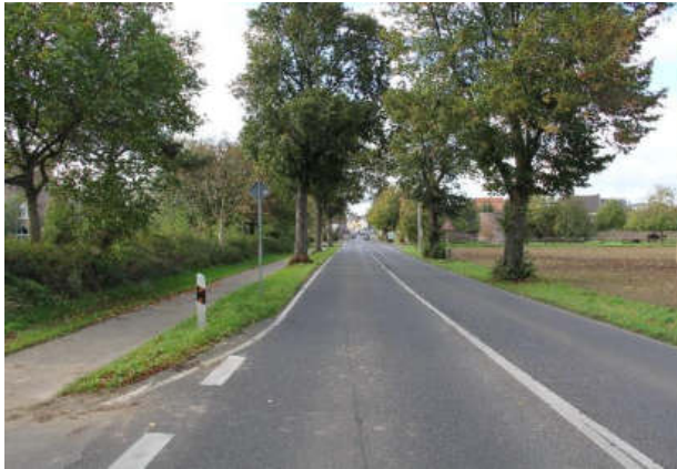
Abb. 125: Undefinierte Ortseingangssituation, fehlende Radinfrastruktur und einseitiger, schmaler Gehweg
