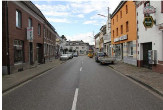
Abb. 106: Undefinierter Straßenraum und rein technischer Straßenausbau ohne Aufenthaltsqualität und Grünelemente
