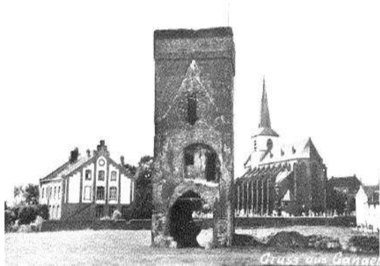
Abb. 34: Der alte Burgturm vor der Restaurierung
