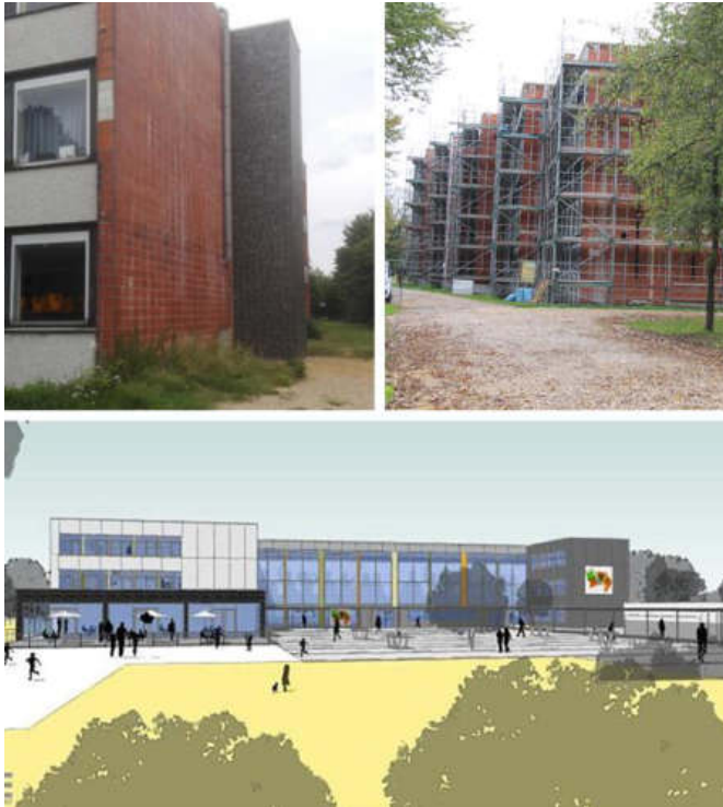
Abb. 12: Sanierung und Quartiersöffnung Haus der Jugendlichen
