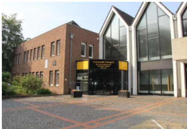
Abb. 137: Rathaus mit energetischem Sanierungsbedarf und mangelnder Barrierefreiheit
