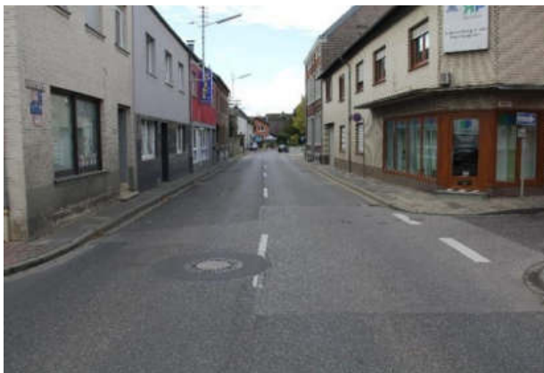
Abb. 107: Störende Architektur und enger Straßenquerschnitt mit zu schmalen Gehwegen und fehlender Radinfrastruktur
