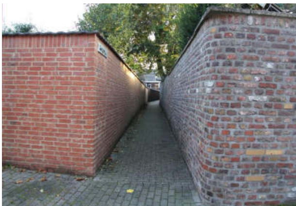
Abb. 122: Fußläufige Wegeverbindungen im Ortskern über ein Gassennetz (Synagogengasse) Fotos: Planungsgruppe MWM (2020)
