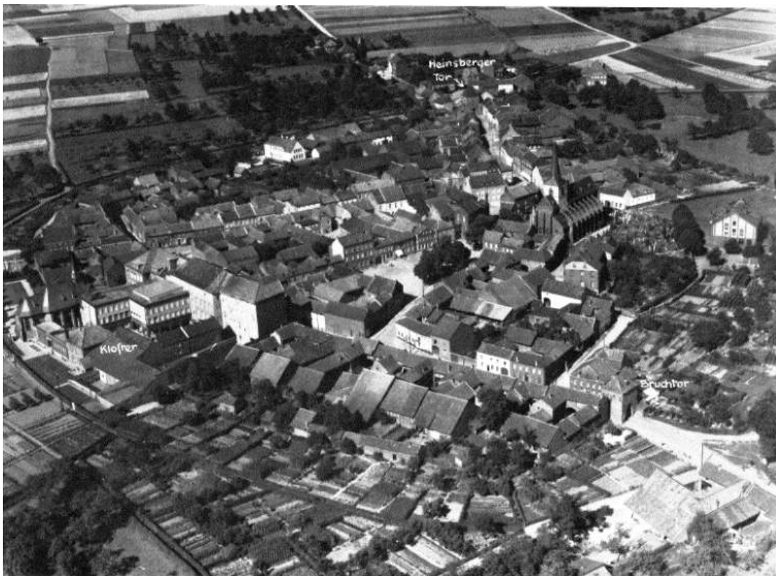
Abb. 36: Schrägaufnahme des Ortskerns von Südwesten um 1930
